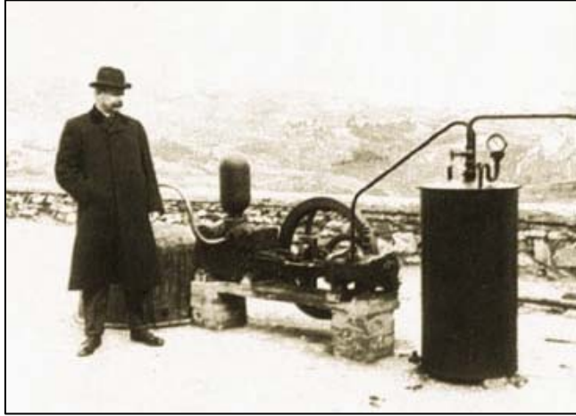
Fig. 2.2 En 1904 se produce, por primera vez en el Mundo, electricidad con vapor geotérmico
