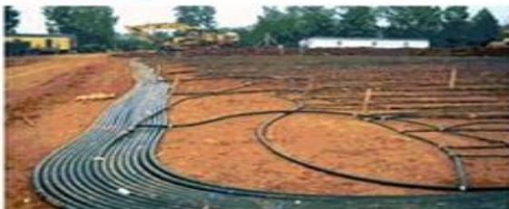
Disposición horizontal de una tubería
