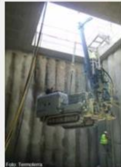
Introducción de la perforadora
