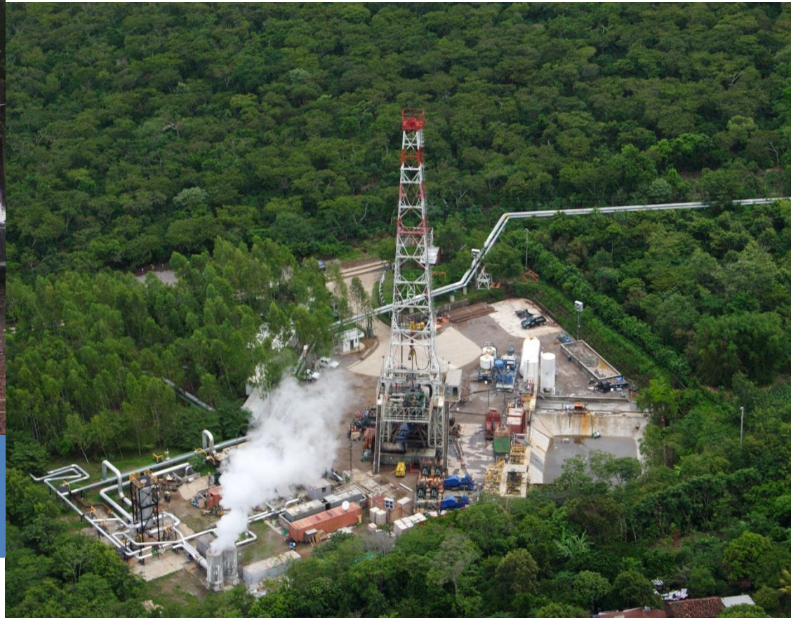
Perforación de un pozo geotérmico de diámetro comercial
