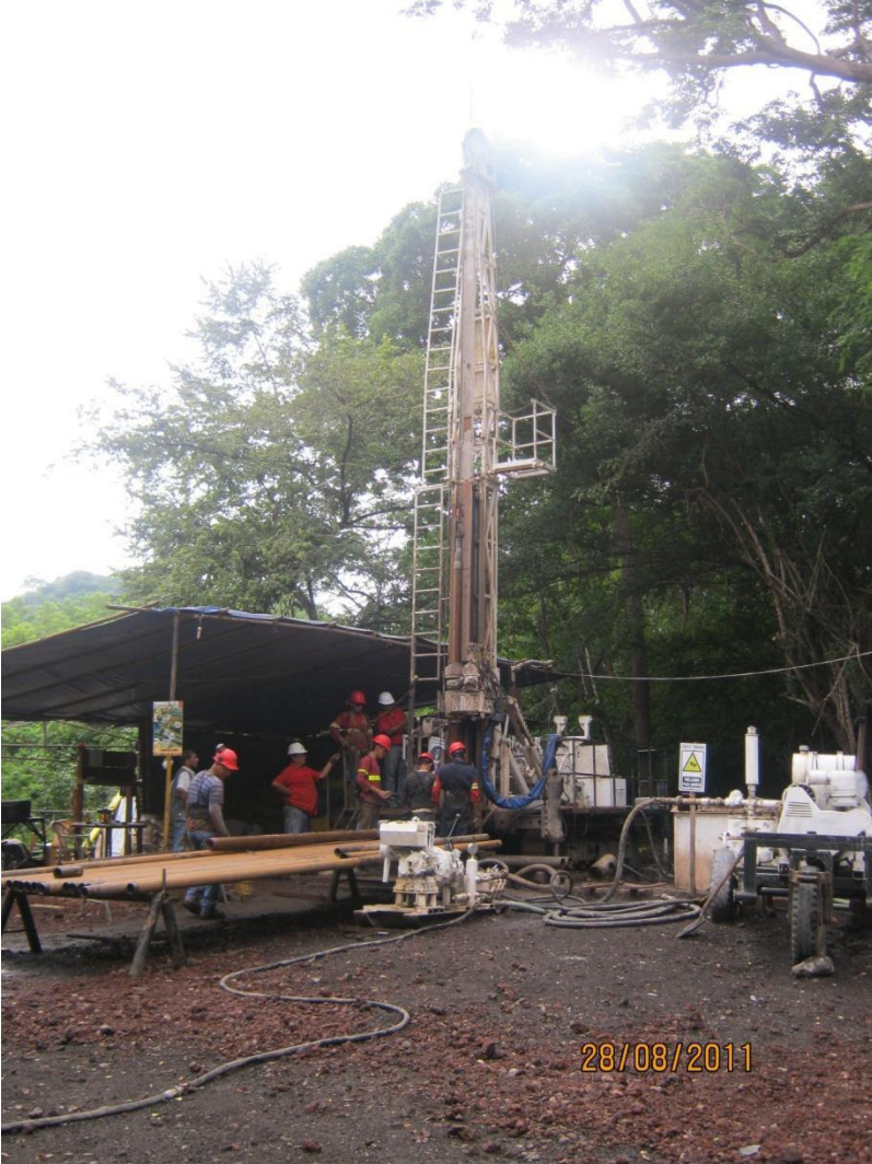
Perforación de un pozo geotérmico exploratorio de pequeño diámetro (diamantino, núcleo continuo)
